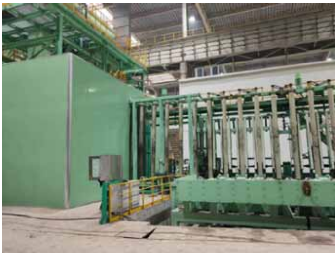
Obr. 1: Přimo před tryskacím zařízením jsou plechy o tloušťce až 160 mm a výšce až 4 100 mm zvednuty do svislé polohy a pomocí válečkového dopravníku dopravovány do tryskacího systému. Tím procházejí rychlostí až 7 m/min.
