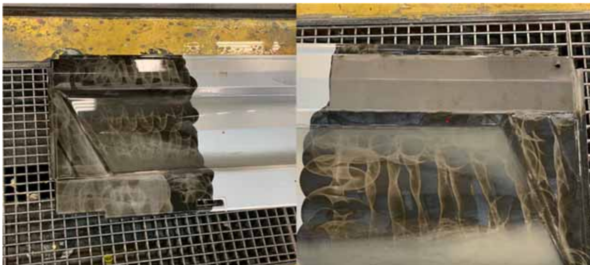
Čištění vysokým tlakem vody při bezpečném odstranění nátěrů po vrstvách
